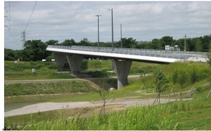
B – le viaduc
