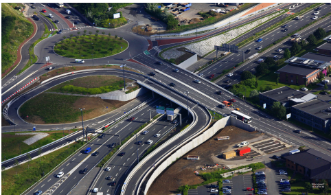
E- 2 parois clouées pour permettre la création de l'accès direct Grand Stade
