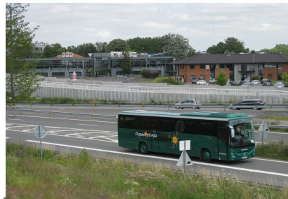
D - 2 murs de soutènement le long de synergy park
